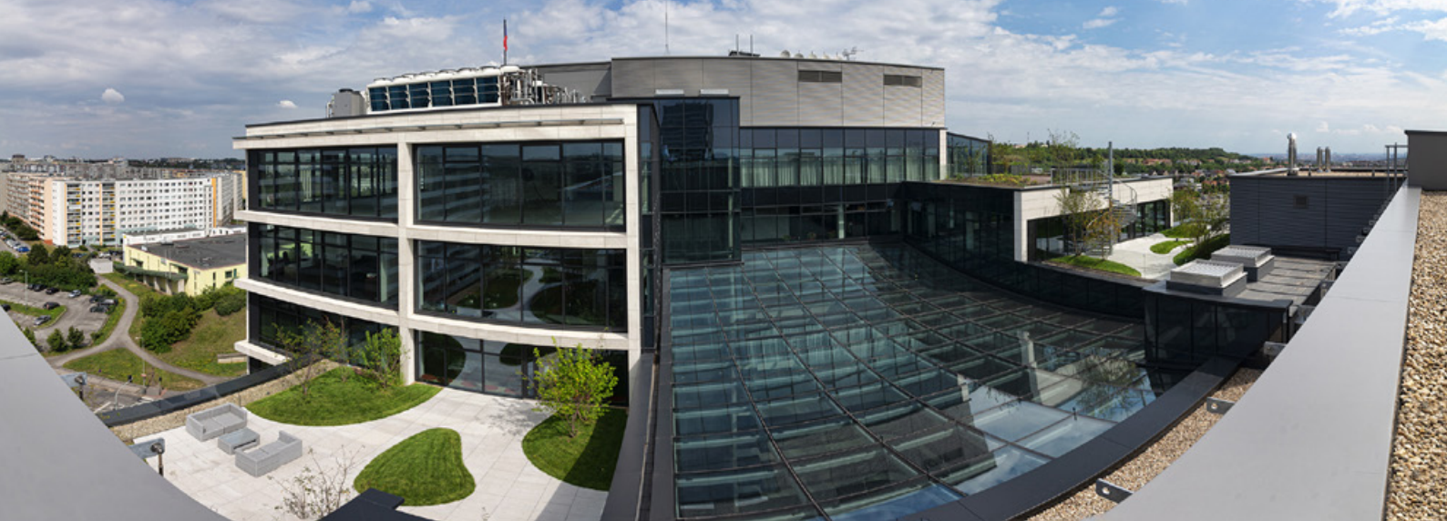
▲ Pro administrativní budovu Aspira Praha jsme realizovali kompletní dodávku obvodového pláště stavby včetně zastřešení atria.
