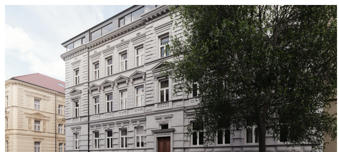
BYTOVÝ DŮM PLZEŇ
